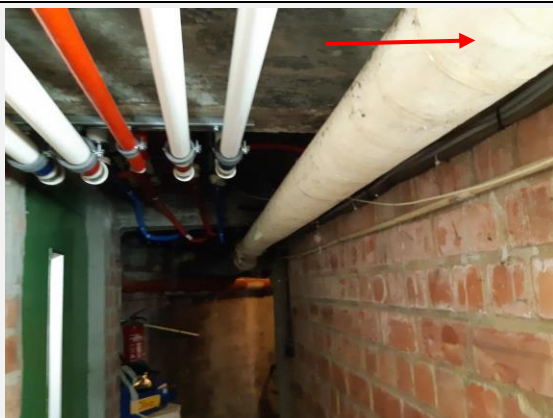
Foto('s) bron: 1, leidingisolatie (gips (isolatie))
